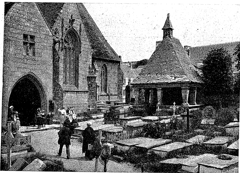
CHAPELLE FUNÉRAIRE, voisine de l'Église, dans le cimetière de Saint-Jean-du-Doigt (Finistère). Le toit de cet édicule, de 1577 (Renaissance), est porté par des piliers trapus. Un lanternon le domine. Cliché Lévy-Neurdein.
