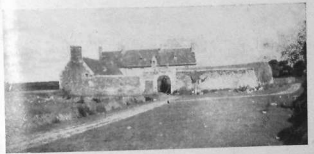
A : Ancien manoir du Mezou. Cour fermée
