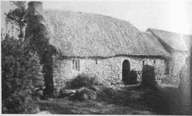
A : Chaumière Garven à Kerlouzern. (Propriétaire; 7 ha). Etable sous le même toit à droite. Pas de porte de communication intérieure.
